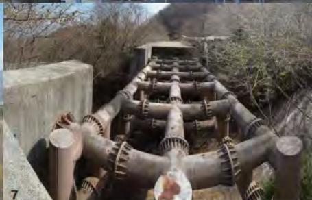
早雲地獄周辺は危険防止のため立ち入りが規制されていますので、麓から眺める事になります。ケーブルカーの中強羅駅近くの左岸導流堤上に作られた展望台(地図a 写真1)と、ユネッサン第4駐車場となりにある右岸導流堤上に作られた展望台(地図b 写真6)からは早雲地獄と下流の砂防施設をよく見渡すことが出来ます。また、この施設は土石流を食い止めるための砂防施設なので貯砂容量を確保するために鋼製の構造物を使用したスリット式の構造物が使用されています(写真7)。
